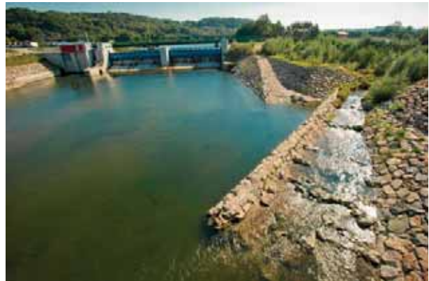
Wasserkraftwerk in Kemmelbach; rechts naturnaher Beckenpass
