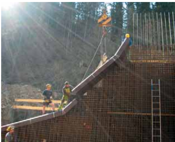
2012 betrugen die Aufwendungen für die Wildbach- und Lawinerverbauung rund 140 Mio. Euro.
